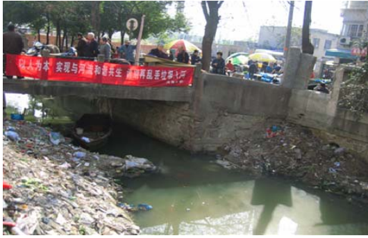
(c) Tampak Sungai Xuxi tepat di Jembatan Xiaomu
